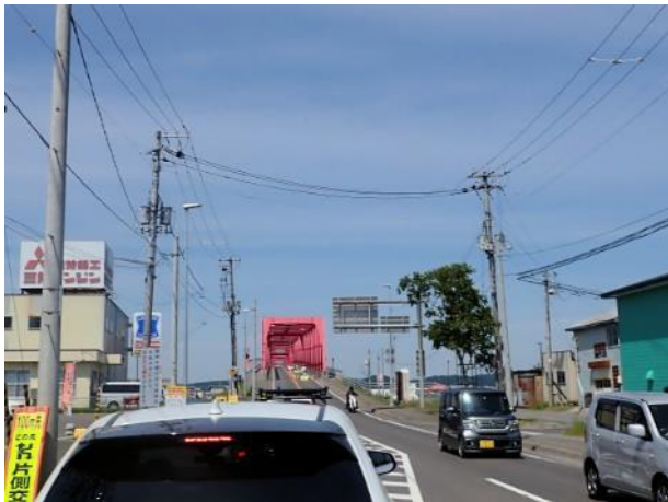
写真 207. 赤い厚岸大橋
