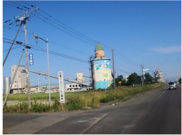
写真 271. コンクリートサイロ
