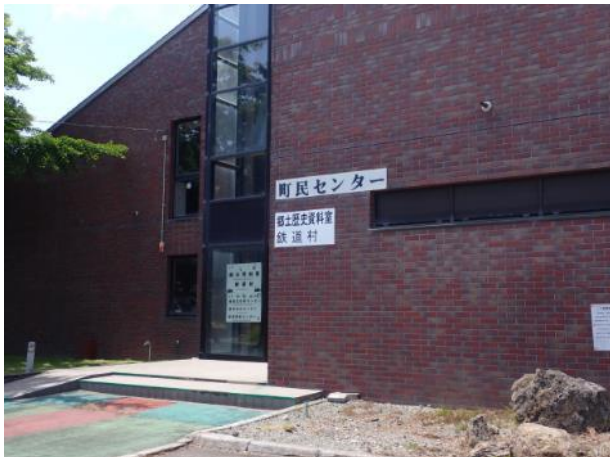
写真 312. 長万部町民センター
