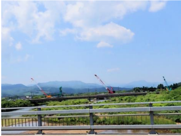
写真 310. 新幹線の橋の工事
