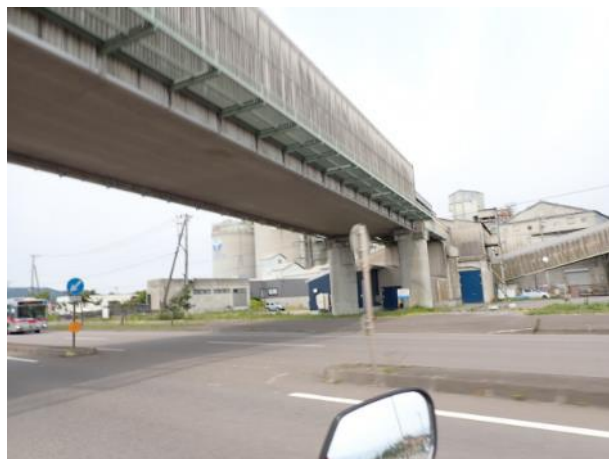
写真 360. 工場と繋がる栈橋
