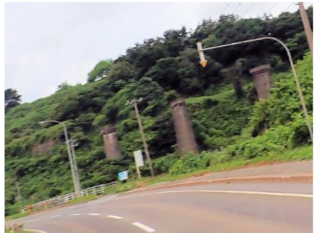
写真 379. 櫃ノ下橋梁跡の橋脚
