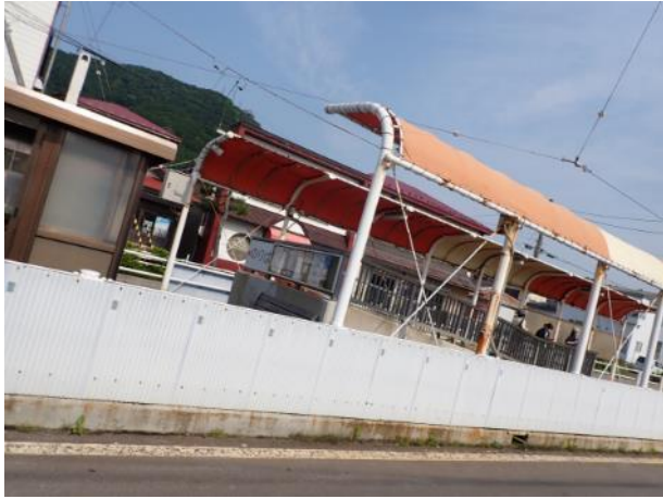
写真 347. 路面電車の停留所
