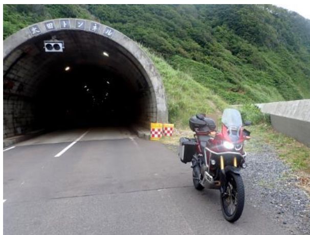
写真 414. トンネル出口
