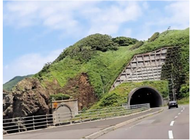
写真 459. 新旧の西河トンネル
