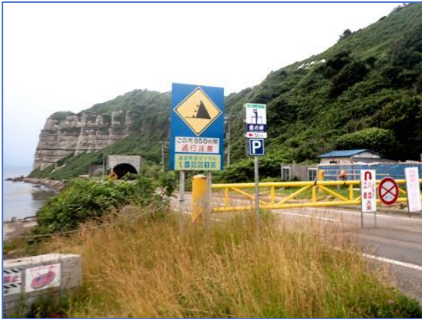
写真 405. 館の岬の手前で通行止め
