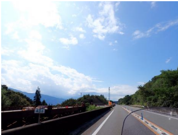
写真 23. ガラガラだけど 4 車線化工事中
