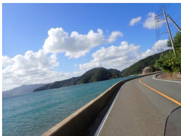
写真 152. 青海島の県道 283
