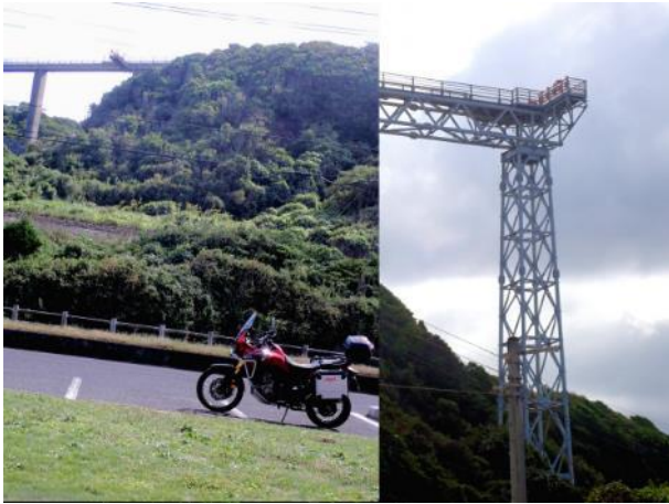
写真 174. 萩・岩見空港の誘導灯
