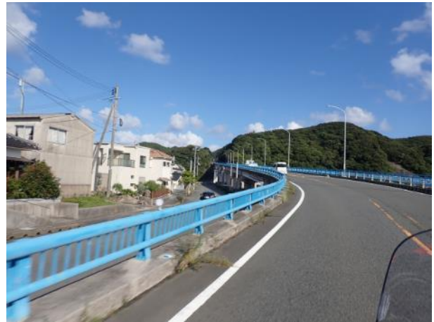
写真 142. 青海大橋に入る
