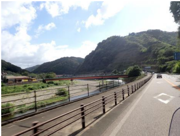
写真 176. 高津川沿いの国道 9
