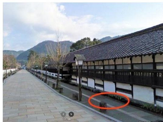
写真 200. 養老館補修前ストリートビュー
