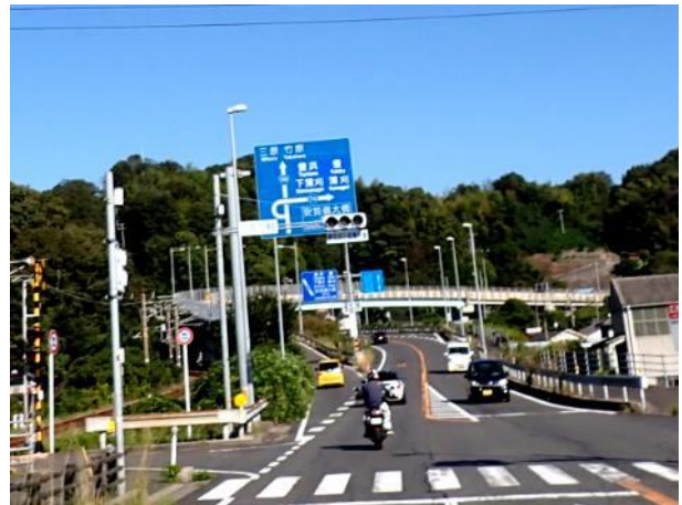
写真 240. 飛島海道の入口
