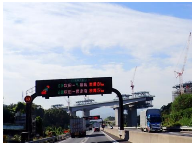
写真 265. 渋滞看板と新名神工事現場
