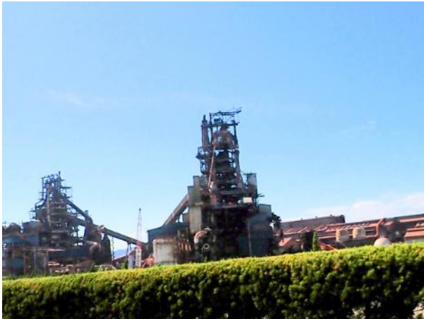
写真 231. 日本製鉄呉製鉄所跡
