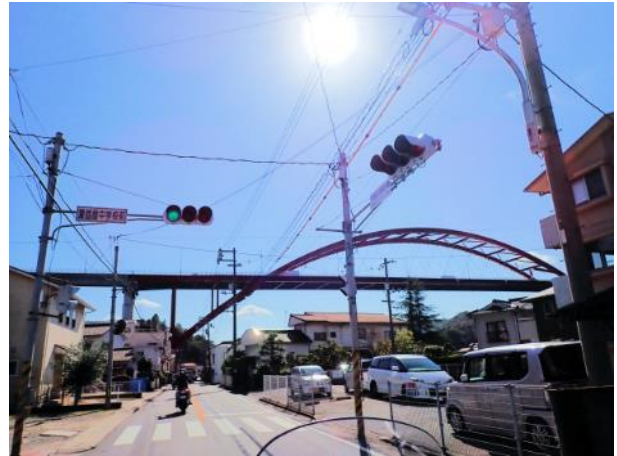
写真 232. 第二音戸大橋の下をくぐる
